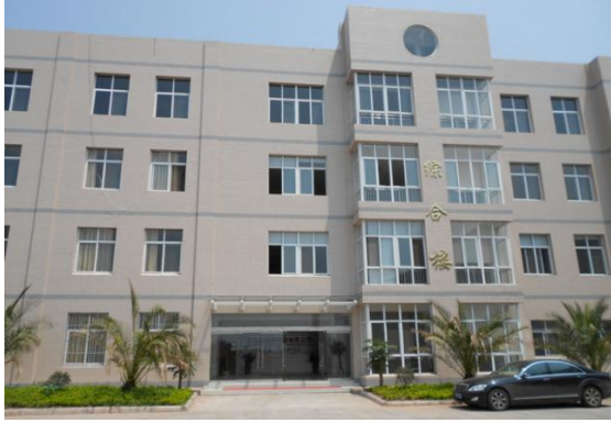
项目位于办公楼四楼
